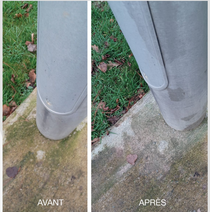
Test sur sol en béton
