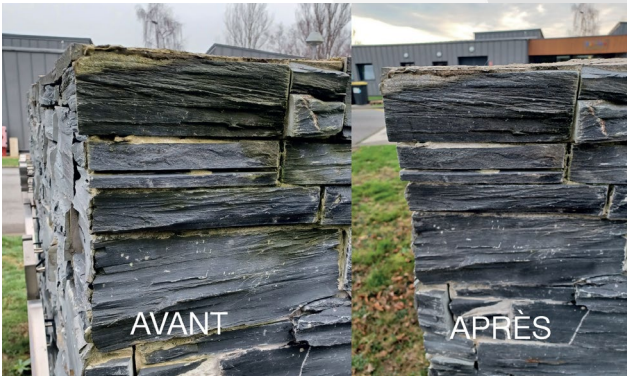
Test sur parement pierre-ardoise
